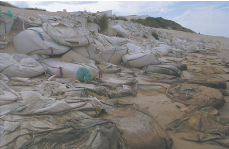
■ (Mau) aspecto dos sacos de areia no Bom Sucesso quando a “aberta”, num dos seus caprichos, se deslocou para sul e pôs em perigo as construções na areia. Já os que agora foram depositados na Foz do Arelho estão previstos ficarem completamente tapados com areia. Será?
