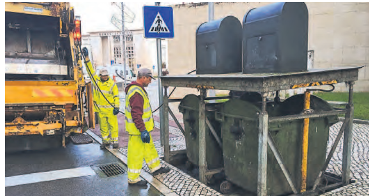
Os contentores subterrâneos têm um sistema hidráulico. Quando é injectado óleo estes sobem à superfície
