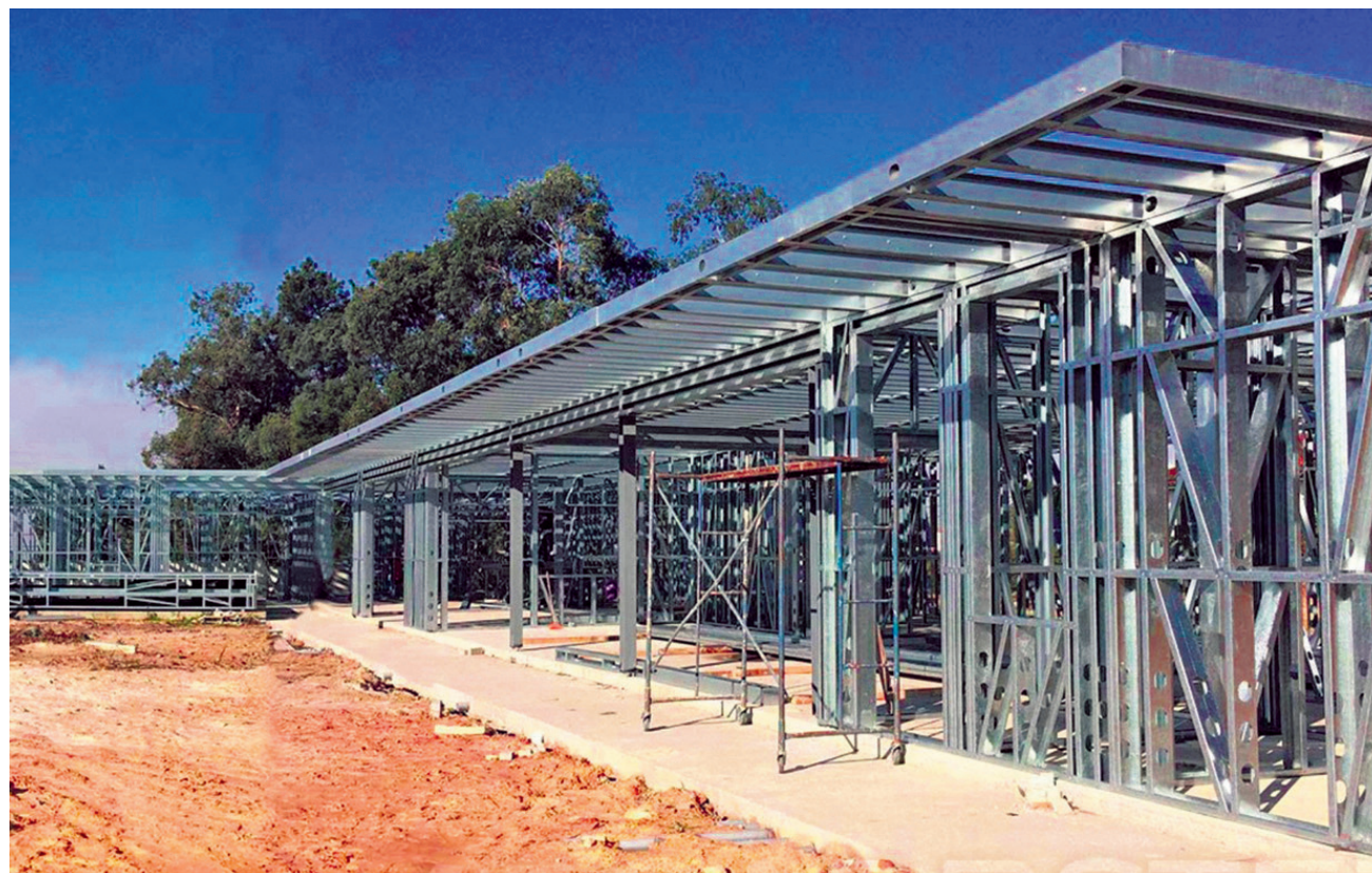
O sistema de construção aço leve pode ser usado para a construção de vários tipos de edifícios
